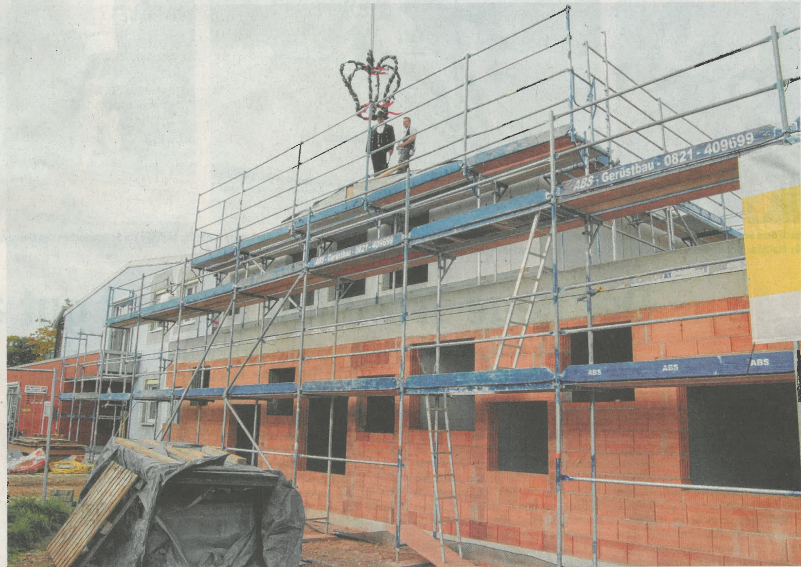
Die Zimmerer der Baufirma Wiedemann & Bzduch sprachen den traditionellen Richtspruch auf dem Rohbau des neuen Kindergartengebäudes an der Greifstraße in Bobingen. Foto: Anja Fischer
